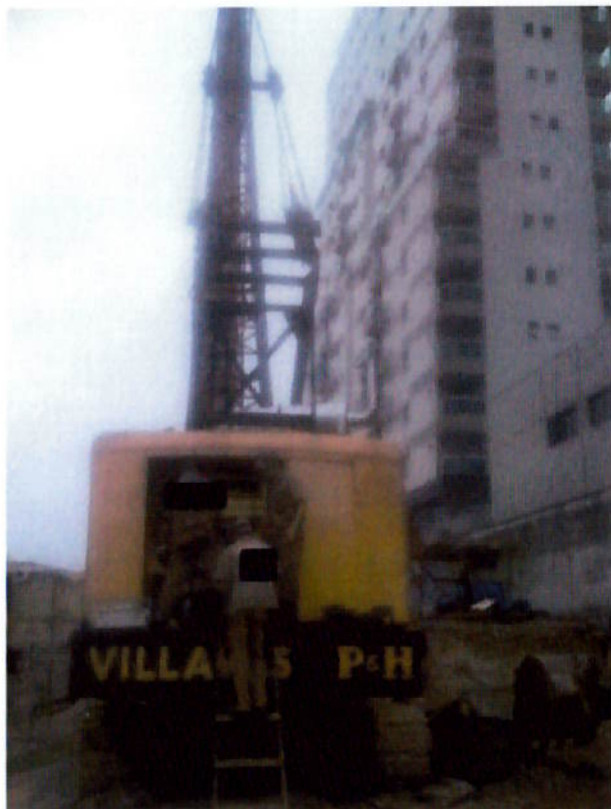
Figura - 4.4 Montagem do silencioso novo Fonte: (Coleção do Autor, 2009)
