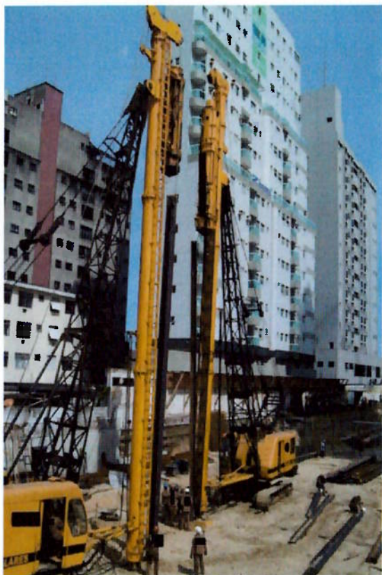
Figura 2.1 - Colocação do perfil Fonte: (Coleção do Autor, 2009)
