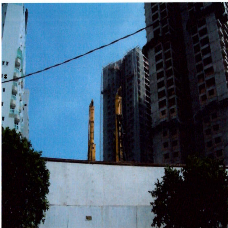
Figura 4.1 – Vista da obra – parte de trás da obra Fonte: (Coleção do Autor, 2009)
