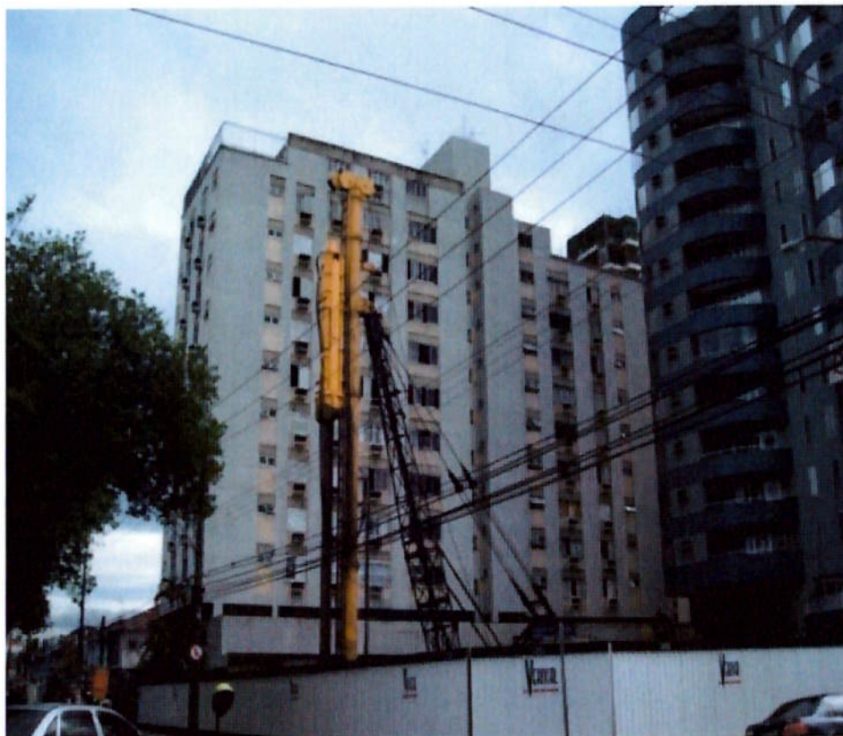
Figura 4.12 – Martelo na obra com a saia Fonte: (Coleção do Autor, 2009)
